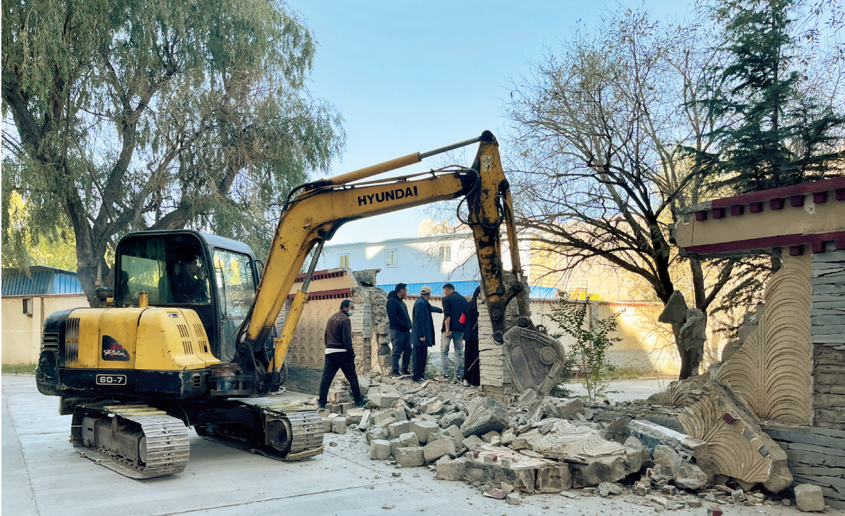
图为违建拆除现场。
